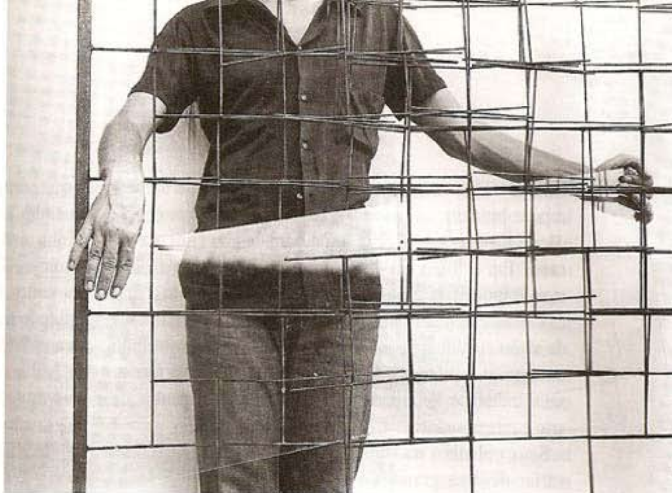
Montagem da obra
